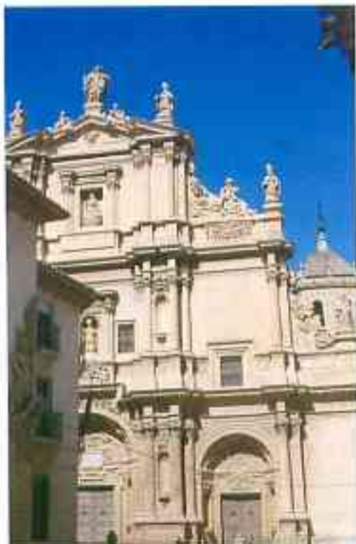
Collegiata de San Patricio: fachada principal.
